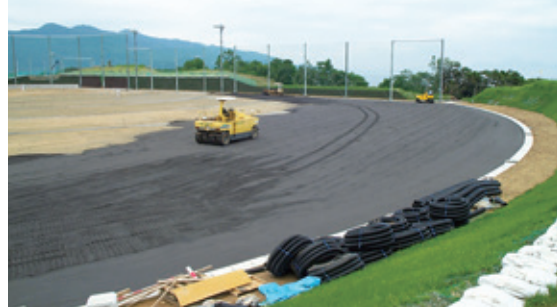
グラウンド工事 施工例(長崎県 海星学園)
